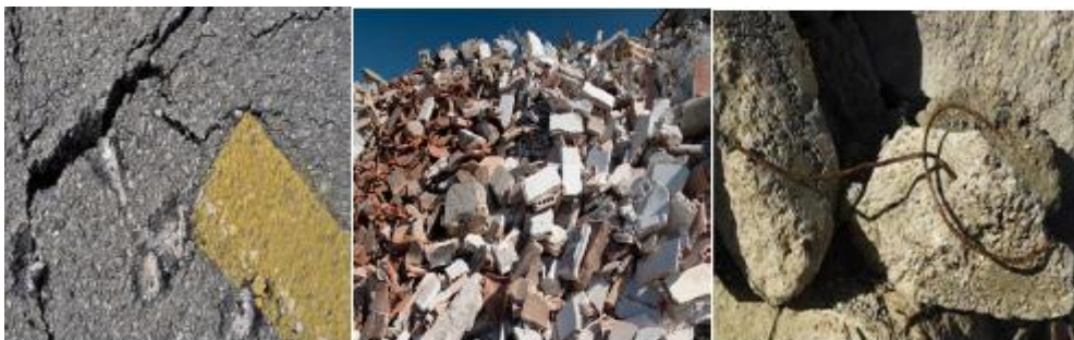
Figure III-4: Gravats à recycler
