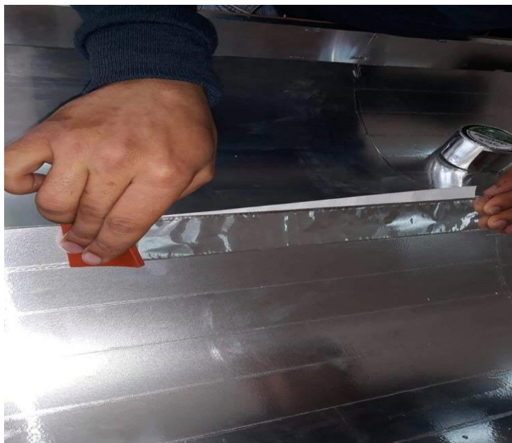
Fig.IV.4. Application du scotch aluminium adhésif sur le fer blanc.
