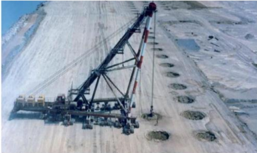
Figure 1. 4. Chantier d'un compactage dynamique profond (Compactage dynamique à très haute énergie (4000 t.m) aéroport de Nice (1978).
