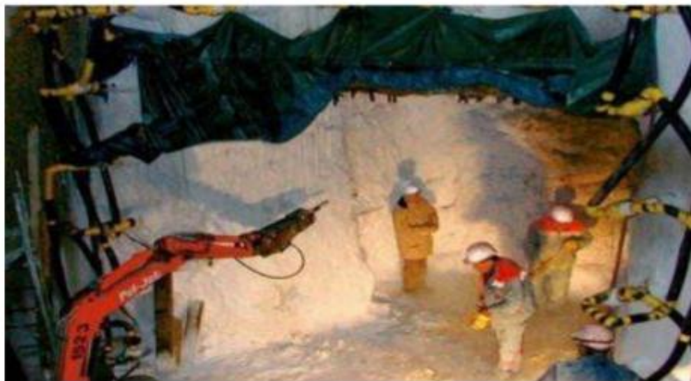
Figure 1. 9. Amélioration par congélation (Sotraisol fondations).
