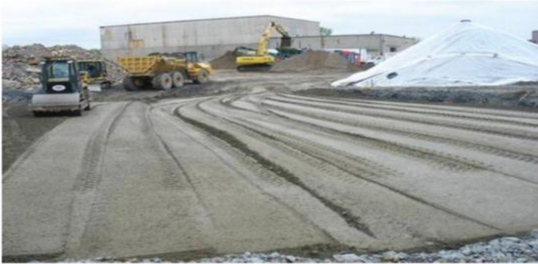
Figure 1. 15. Chantier de traitement du sol au ciment.
