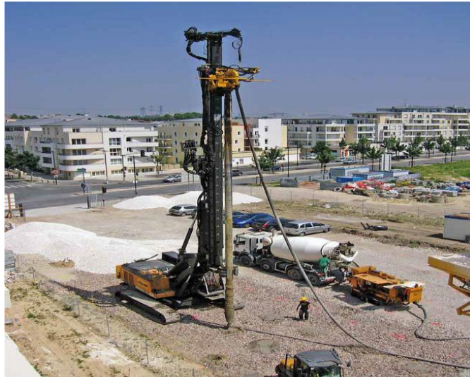
Figure 2. 1. Grands travaux placement d'inclusions.
