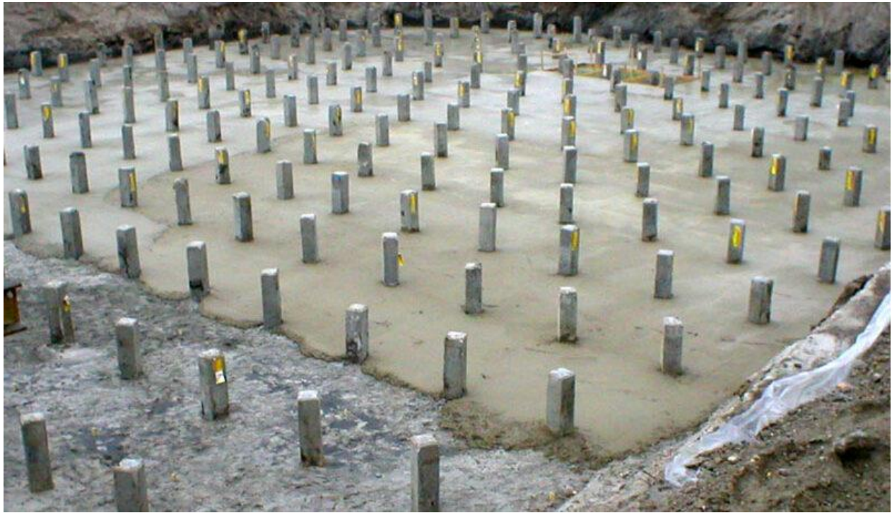
Figure 2.7. Système de fondation par pieux métalliques préfabriqués.
