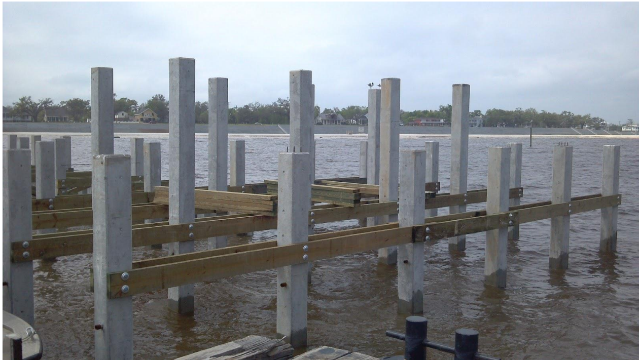
Figure 2.8. Pieux en béton armé.
