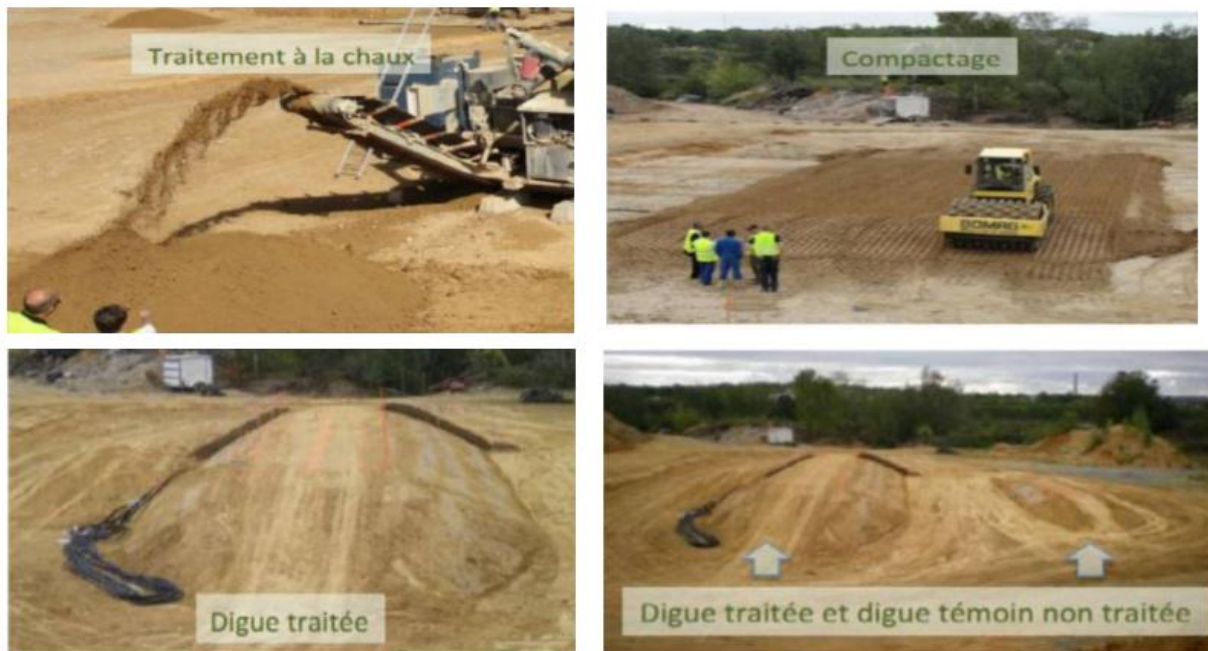
Figure 1. 14. Traitement à la chaux (Projet Lhoist-Chantier Pilote).
