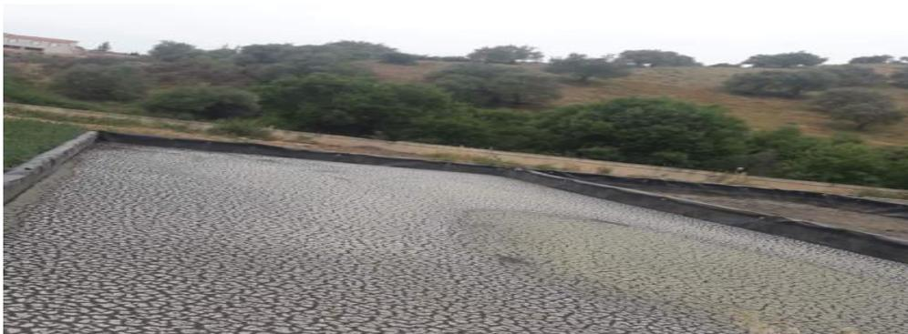
**Figure 13** : Lits de séchage des boues
