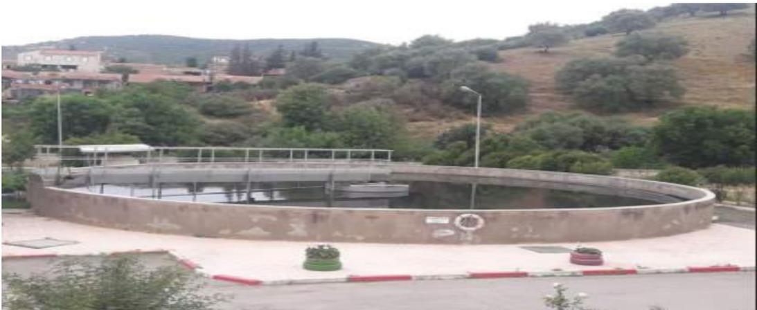
**Figure 09:** Décanteur secondaire
