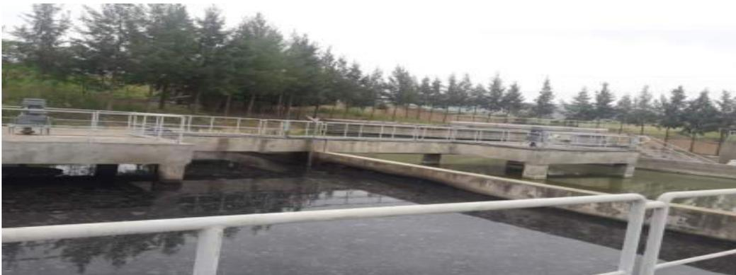
**Figure 10 :** Stabilisateur avec aérateur de surface
