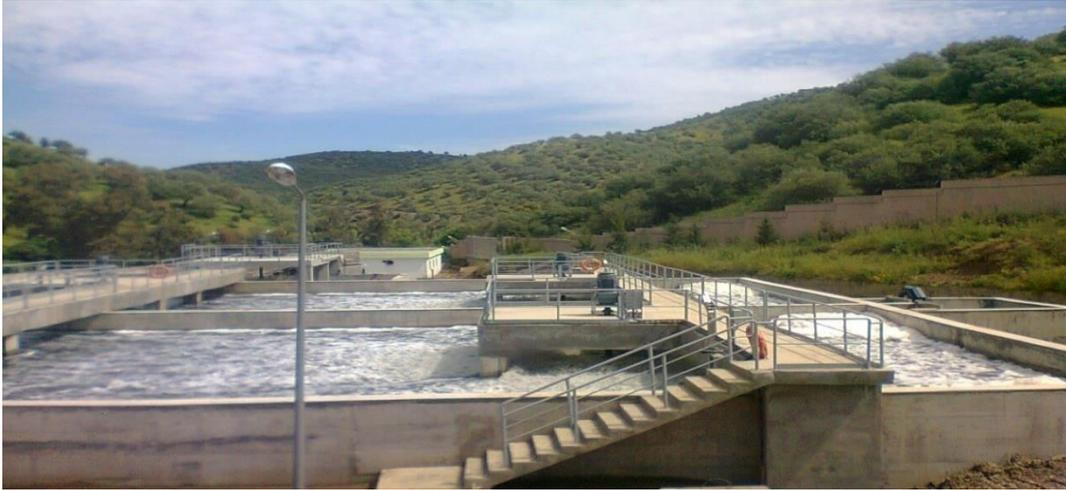
**Figure 08:** Bassin d'aération avec aérateur de surface.
