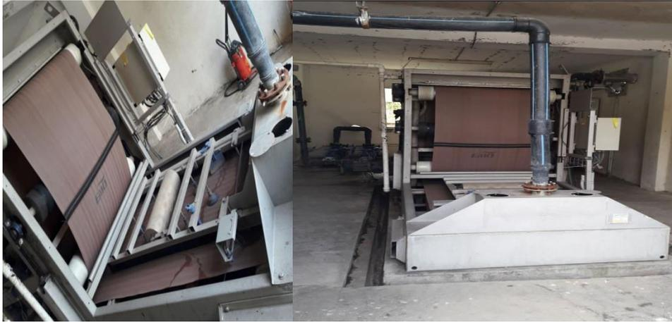
**Figure 12** : Déshydratation mécanique des boues
