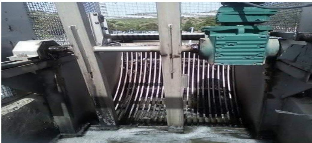
**Figure 05** : Dégrilleur automatique
