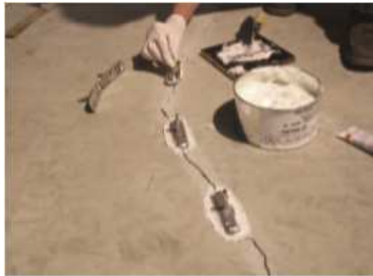
Figure I.9 : fissure en cours de cachetage. [22]
