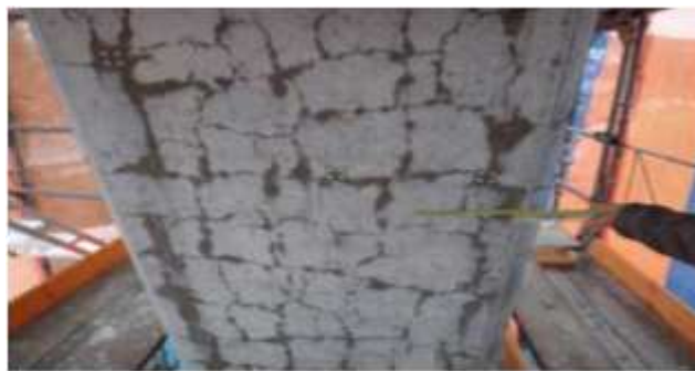
Figure I.4 : épaufrures dues à l'alcali-réaction. [13]
