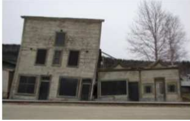
Figure I.6 : tassement différentiel. [13]
