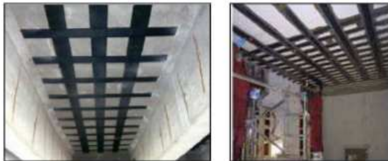
Figure I.14 : Renforcement des dalles en béton armé. [24]
