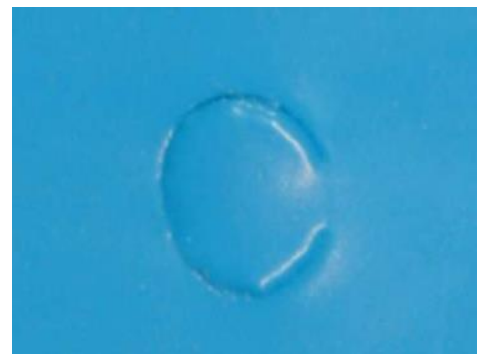
Figure 50: Irrégularité du trou lors de perçage {2}.
