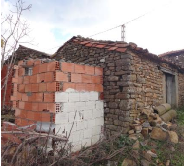
Figure96 : juxtaposition de nouveau à l'ancien.
