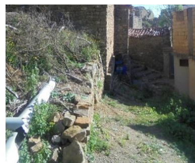
Figure 140 : installation des eaux pluviales.
