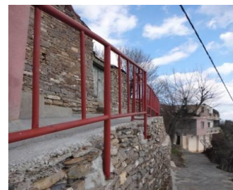
Figure92 : le bétonnage de certaines impasses, des gardes corps en fer forgé.(source ;adane agiles)
