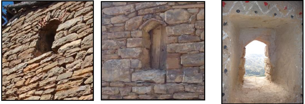
Figure125: L'ouverture est constituée d'un linteau en forme d'arc en
