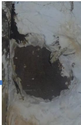
Figure 200 : filet sous toit
