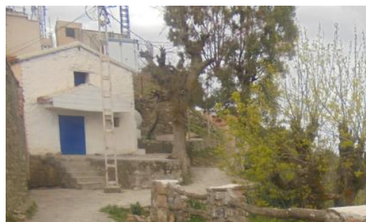
Figure74 : l'jame3 à l'entrée ouest.
