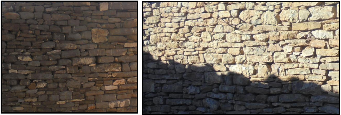
Figure 146 : disposition de la pierre en assise. De forme régulière et irrégulière ((Source auteurs) .
