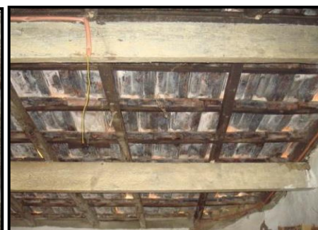
Figure 158: sous toiture par des lattes en bois.
