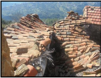
Figure 183: désolidarisation des tuiles.
