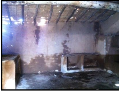
Figure 184: défaut d'étanchéité.
