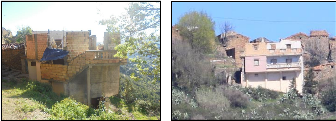
Figure170 : photos des nouvelles maisons en béton, brique.
