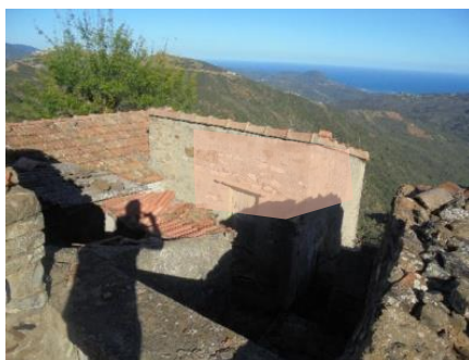
Figure 139 : enduit de ciment
