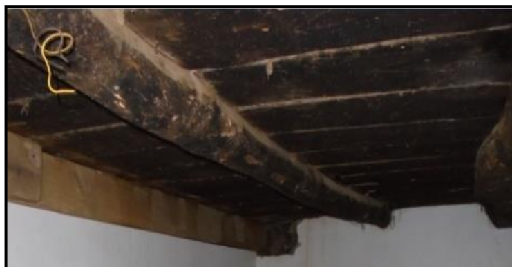
Figure 151 : photos qui montrent les planchers Prise par auteurs
