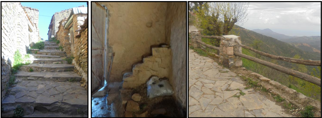
Figure 132 : escaliers Prise par auteurs
