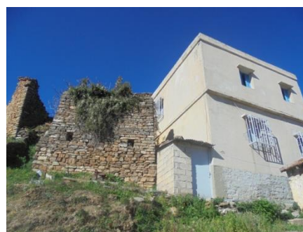
Figure91 : démolition totale de l'ancienne bâtisse.
