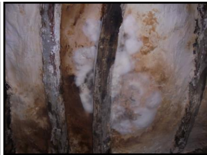
Figure181 : l'effet d'humidité sur le toit.
