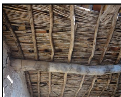
Figure 160 : charpente faite à partir de roseau et les chevrons en bois.
