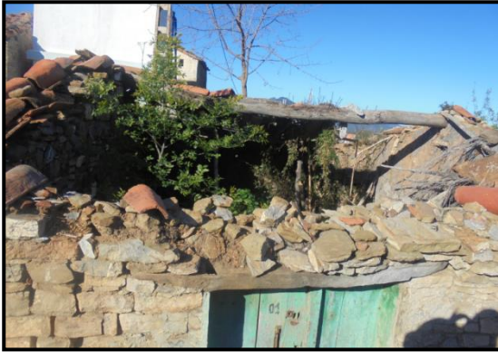
Figure 183: désolidarisation des tuiles.
