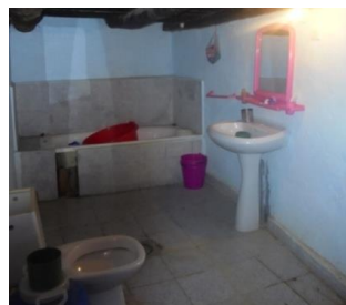
Figure94 : aménagement d'adaynin en sanitaire.
