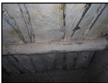
Figure 156: Sous toiture faite par les solives et le mortier de chaux.
