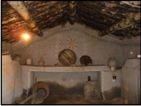
Figure178 : remonté d'eau par capillarité.
