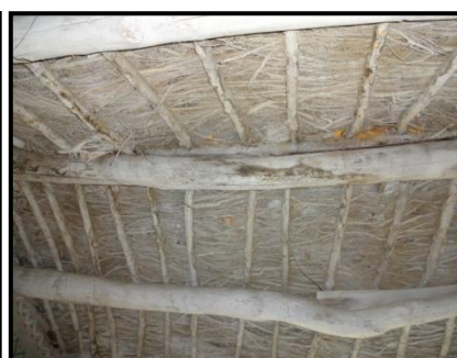
Figure 157: sous plancher fait par les branchages de roseau et les solives.
