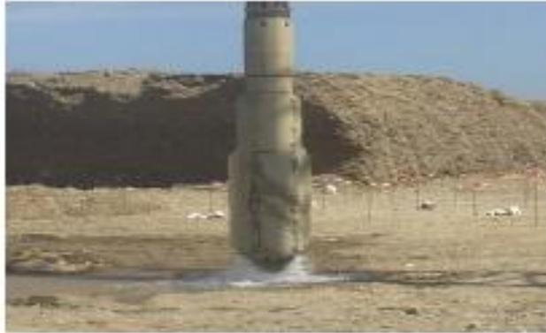
*Figure I.29. Lançage à eau du vibreur.*
