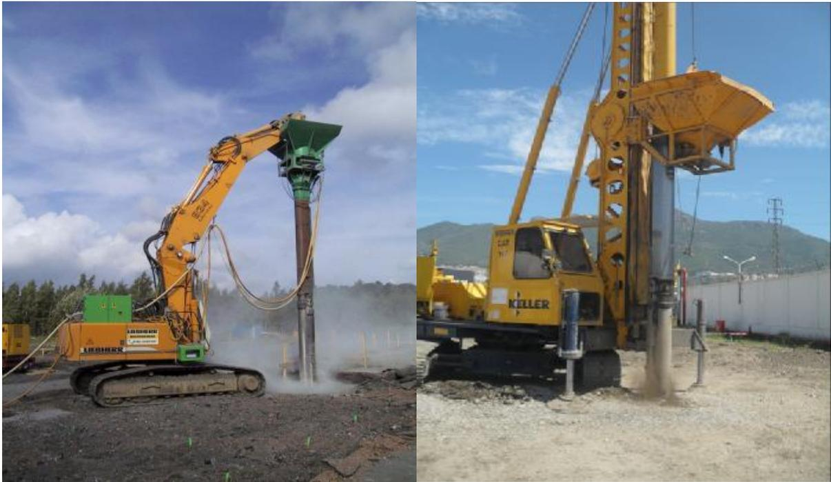
Figure I.32. Outils de réalisation de colonnes ballastées, Chantier Loosen Goelle Sogiopa et chantier Naftal.
