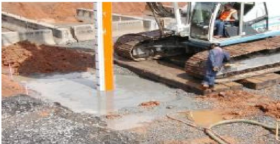
Figure I.21 : l'outil est ancré dans le sol.
