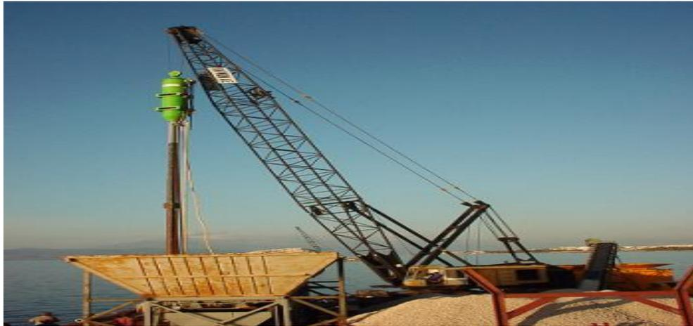
Figure I.35. L'outil de réalisation des colonnes ballastées en mer.
