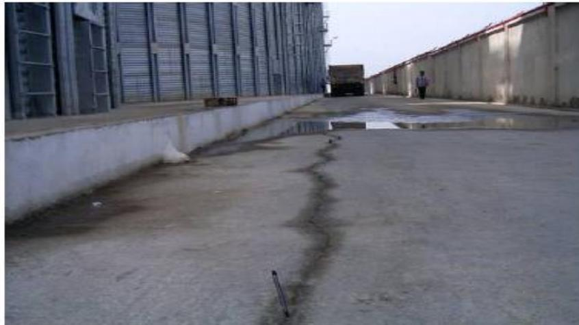
Figure II.17: Fissure de tassement au niveau de la voirie au voisinage du radier.
