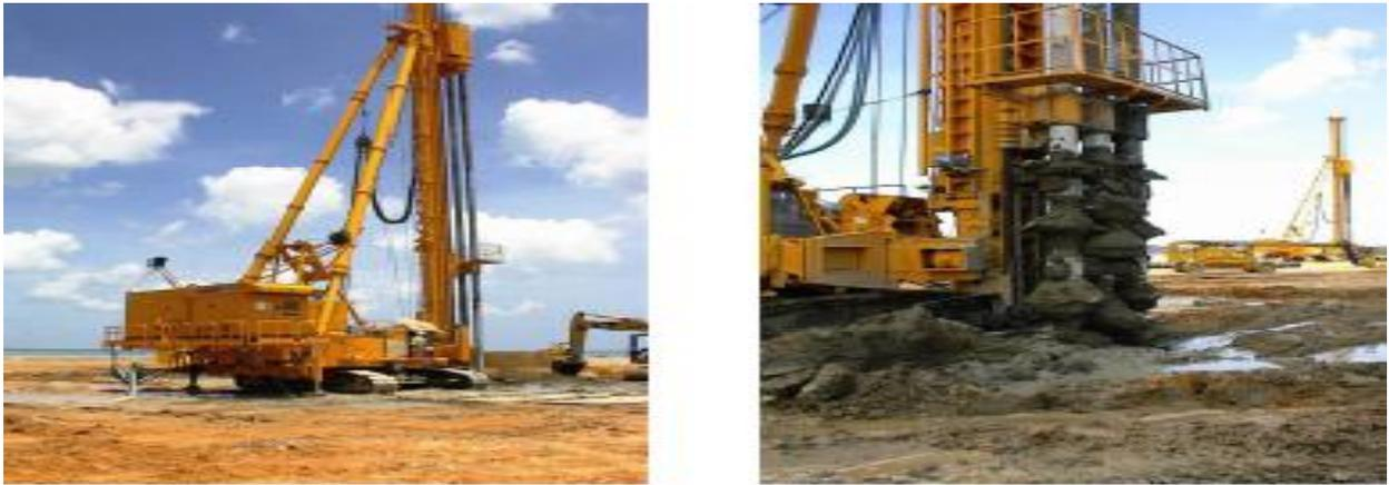
Figure I.18 : un type d'équipement utilisé contenant trois tarières chevauchantes.
