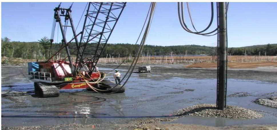
*Figure I.11.Réalisation d'un chantier à la vibroflottation (Vibreur électrique).*
