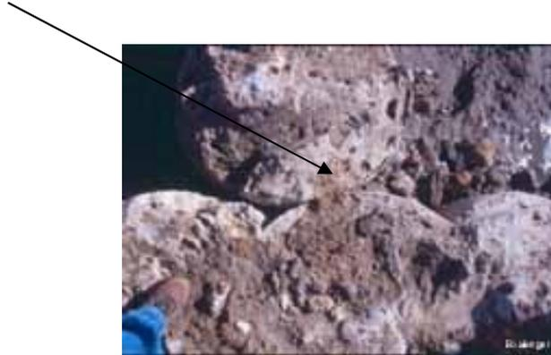
Figure I.23. Non chevauchement des colonnes.
