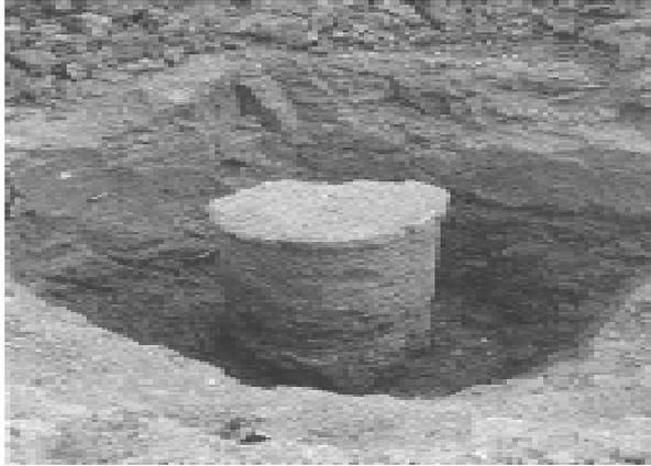
*Figure I.24 – Colonne de sol traité à la chaux.*
