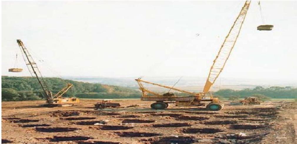
*Figure I.9. Exemple de chantier de compactage dynamique.*
