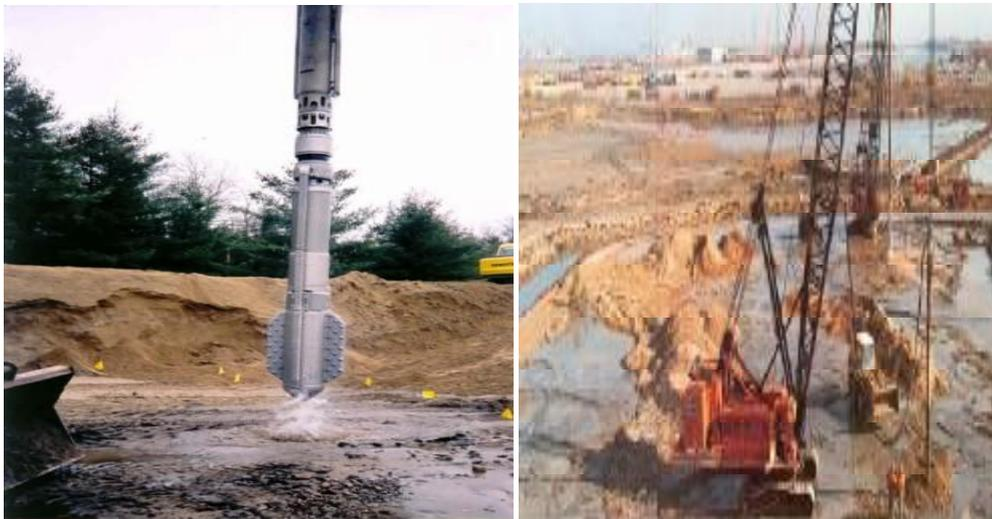
*Figure I .10.Vibreur électrique*
