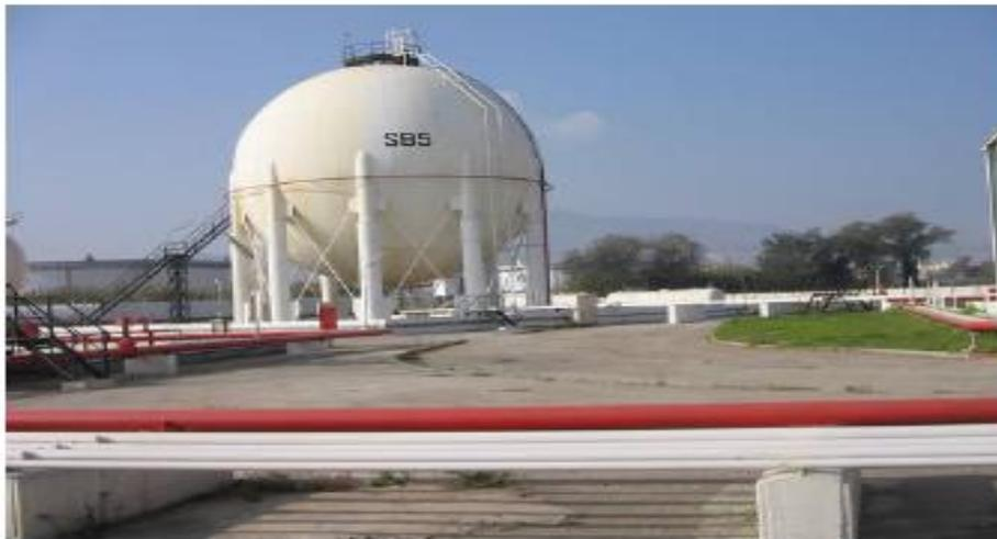
*Figure II.14 : Vue générale de la sphère de stockage de gaz de 3000m<sup>3</sup> Bejaia.*
