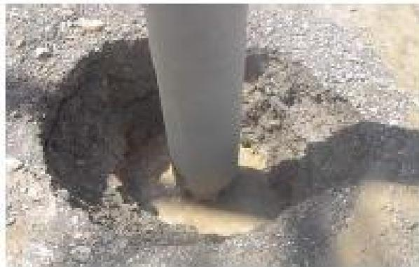
*Figure I.30. L'enfoncement du vibreur.*
