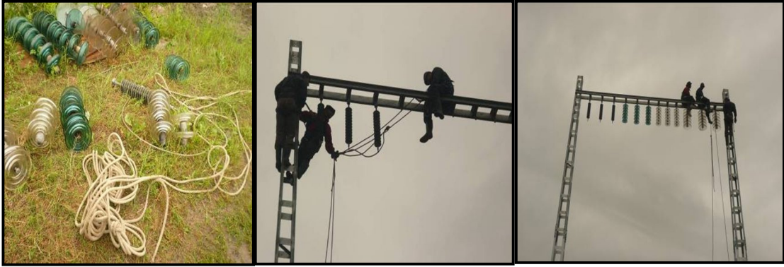
Figure (II.17) : Accrochage des chaînes d'isolateurs
