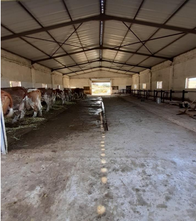
Figure 24 : Bâtiment d'élevage de type moderne (originale 2022)
