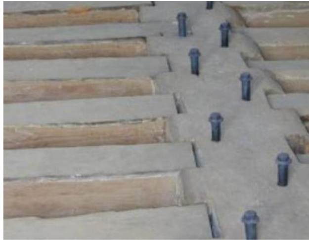
Figure I.11 : connecteurs SBB
