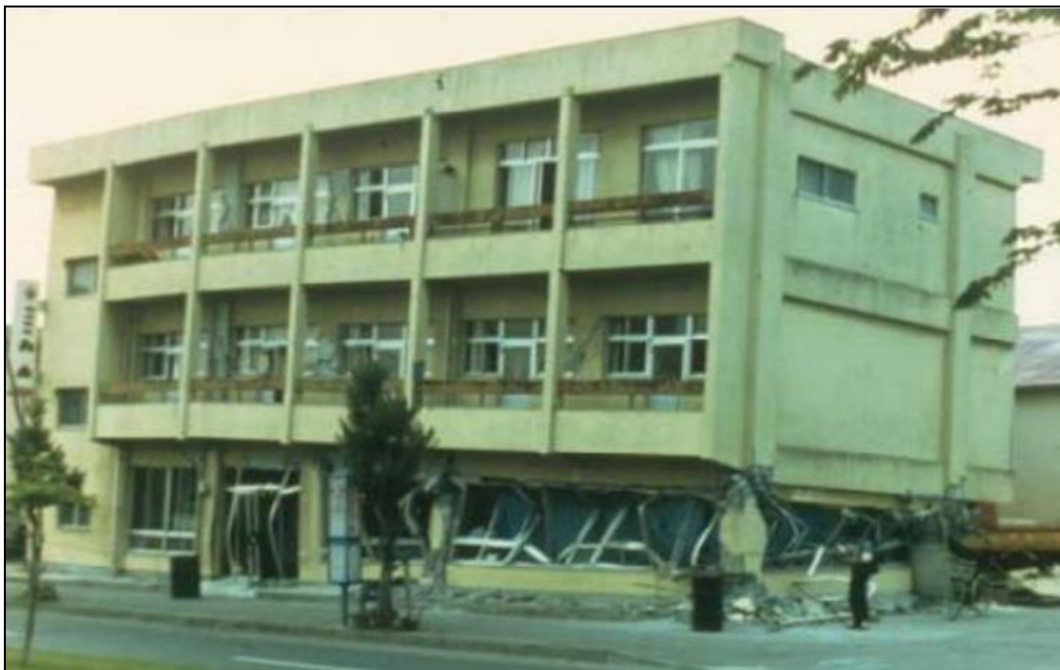
Figure 1.3: Déformation permanente gauchie du bâtiment due à la position excentrée de la cage d'escalier [3].
