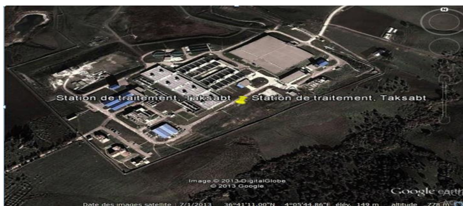
Figure IV.2: Localisation de la station de traitement de Taksebt.
