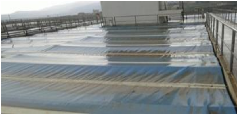
Figure IV.6: Décanteurs (Pulsa tube).
