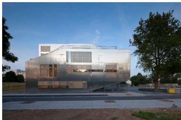
Figure 194 : Façade sud du centre socioculturel l'Arbrisseau.
