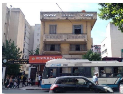
Figure 178: Maison coloniale avants. Source auteurs
