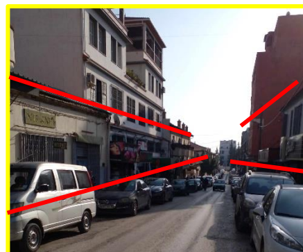
Figure 82 : photo des parois Source : auteurs
