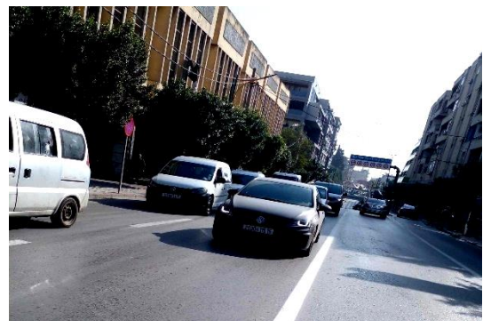
Figure 62: Photo de la voie AbaneRamdane de 1er tronçon Source : auteurs
