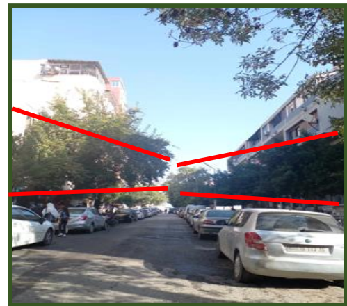
Figure 85 : photo des parois de la rue Acherouche Med Source : auteurs
