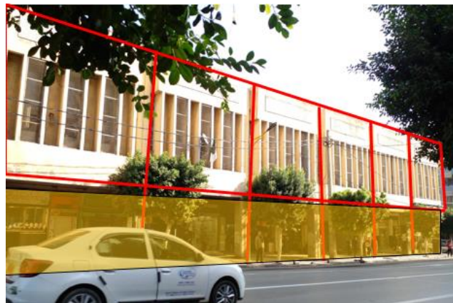
Figure117 : photo du bâtiment de la librairie cheikh Source : traité par auteurs
