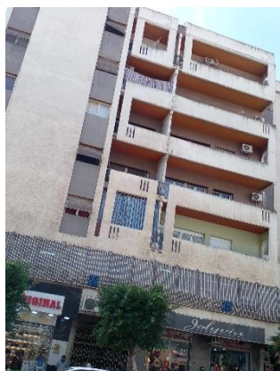
Figure 173: bâtiment d'habitation après Source auteurs
