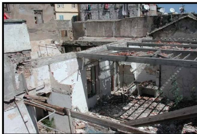
**Figure 11 : Dégradation du bâti de la haute casbah**
