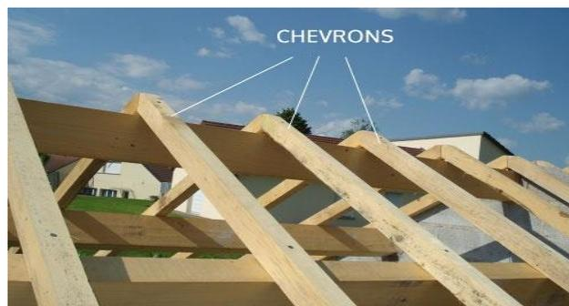
**Figure III.8.5 : la mise en œuvre des chevrons**
