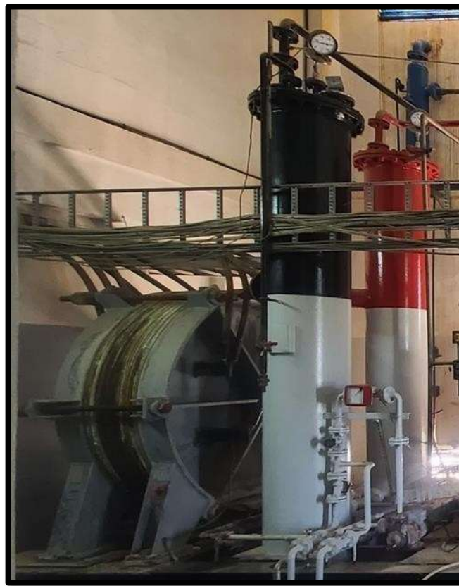
Figure II. 2: électrolyseur + séparateurs
