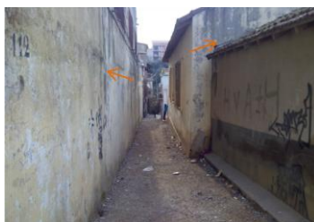
Fig. 139. Etat actuel rue Zraba. Source Auteurs
