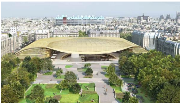
Fig.85. Vue d'ensemble sur la Canopée. Source *
