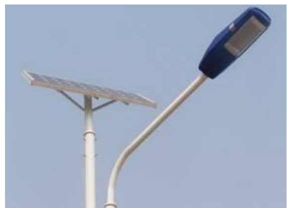
Fig.138. Eclairage du terrain de football à la cité des Fonctionnaires
