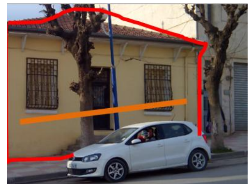
Fig.40. Photo représentant une façade caractéristique de l'entité coloniale. Source auteurs
