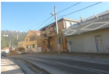
1ères maisons du lotissement Source auteurs
