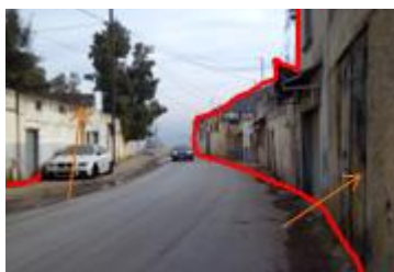
Fig. 140. Etat actuel rue Zraba. Source Auteurs
