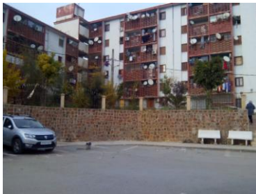
Fig.128. Etat actuel bâtiment de la Cité Le Cadi. Source Auteurs
