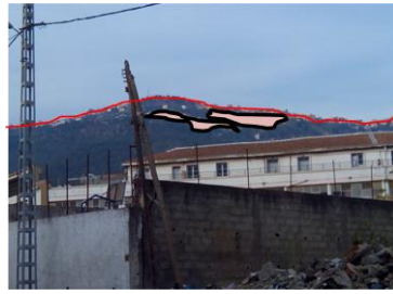
Fig.32. Vue depuis site côté Nord. Source auteurs
