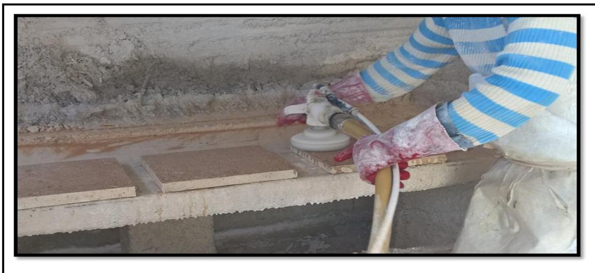
Figure 10 : ponçage des carreaux
