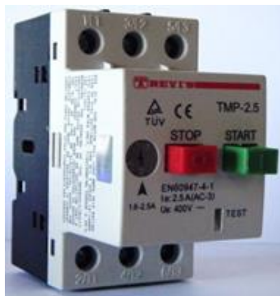
Figure IV-16 : Disjoncteur magnétothermique
