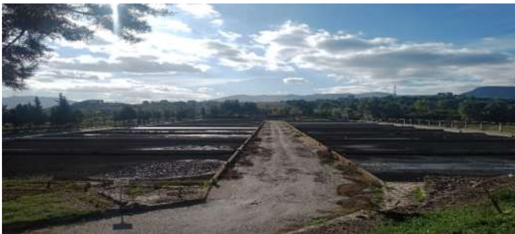
Figure 15: Lits de séchage (originelle ; 2023)
