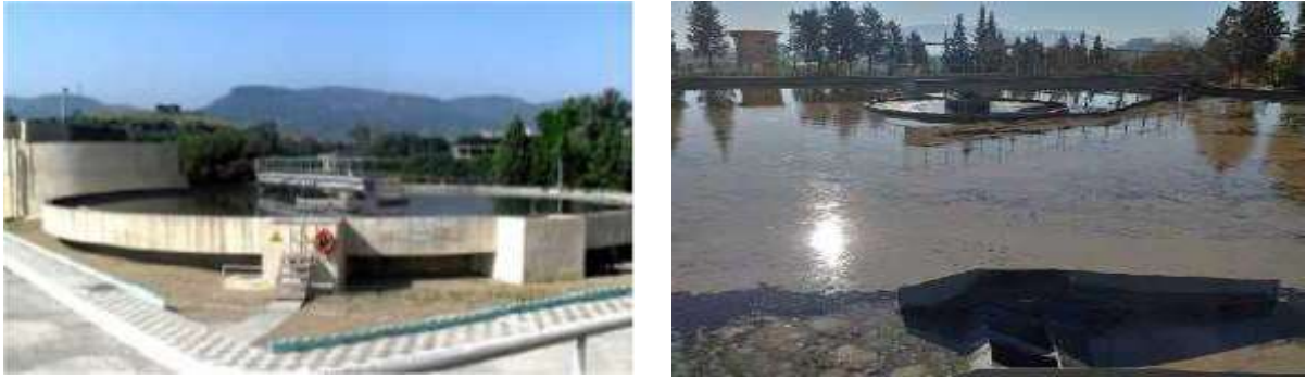
Figure 12 : le clarificateur (originelle; 2023)
