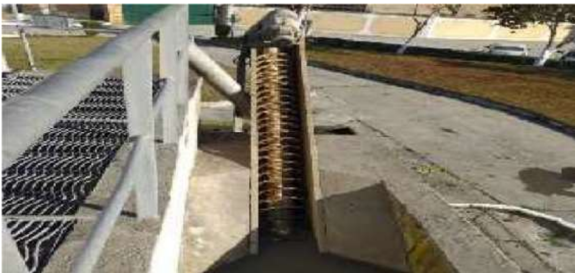
Figure 10 : Vis d'Archimède (originelle ; 2023)
