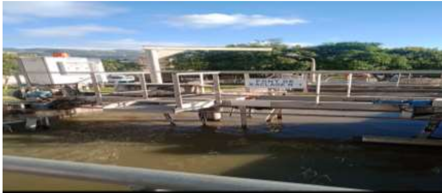
Figure 9: Ponts de raclage (originelle ; 2023)
