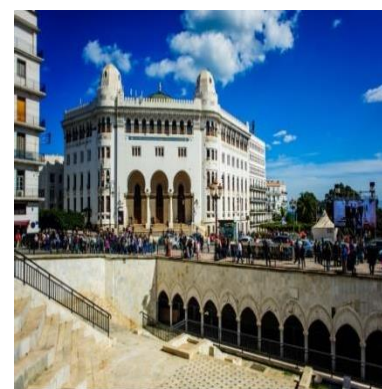
Figure 35 : Grande poste Source : site web « Alger Histoire »
