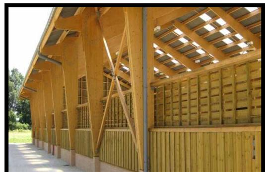
Figure 9: construction en bois lamellé collé.
