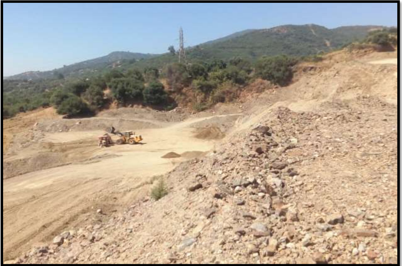
Figure III.11 :la réalisation des voies d'accès
