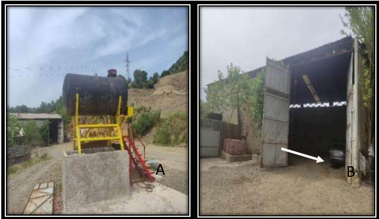
La citerne de gasoil
