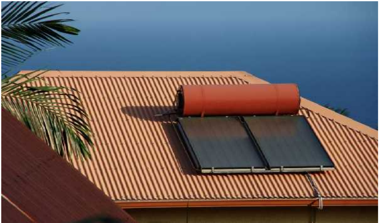
Figure IV-11 : Panneau solaire thermique avec un ballon de stockage. [09]
