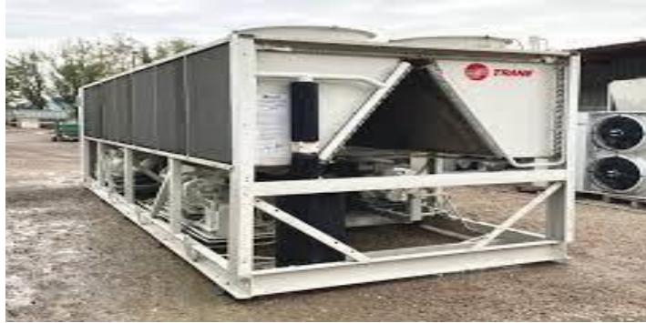
Figure II.3. Groupe à eau glacée « Trane ».
