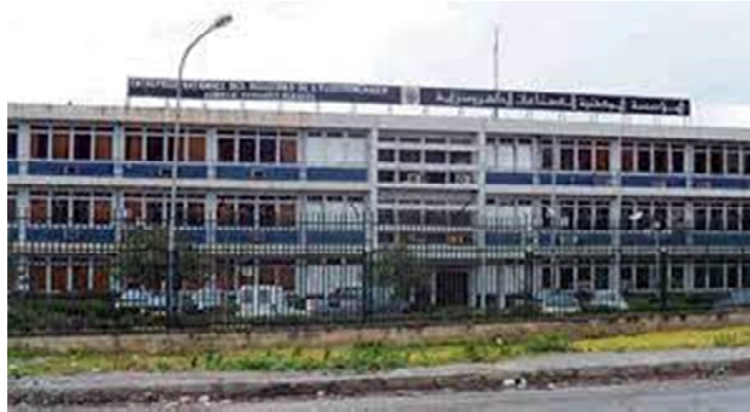
Figure I. Direction de l'entreprise ENIEM.
