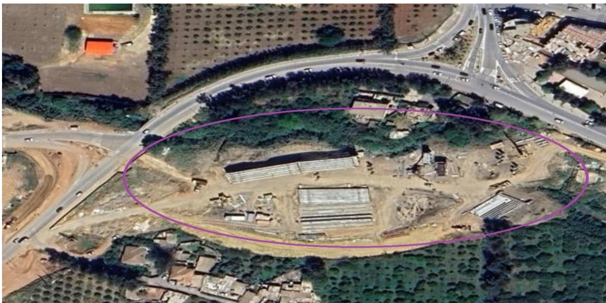
Figure I.1: Vue satellite du site de l'ouvrage (Google Earth)
