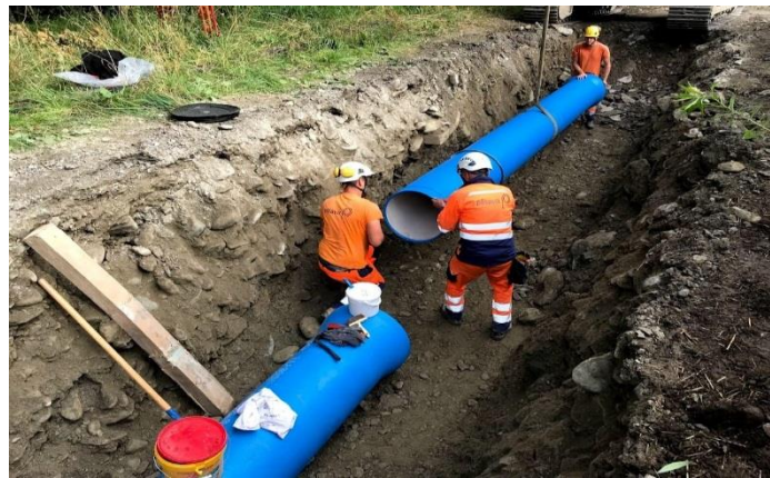
Figure I.15 : pose en tranchée ouverte.
