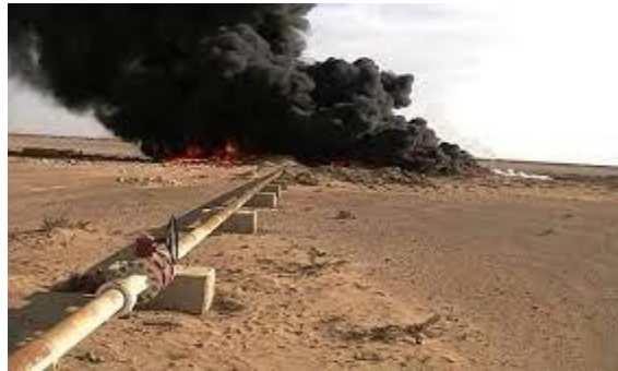
Figure I.9 Incendie causée par une fuite de pétrole [14].
