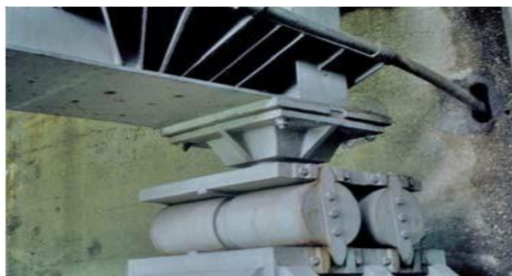
Figure IX.4 : Appareil d'appui en acier.
