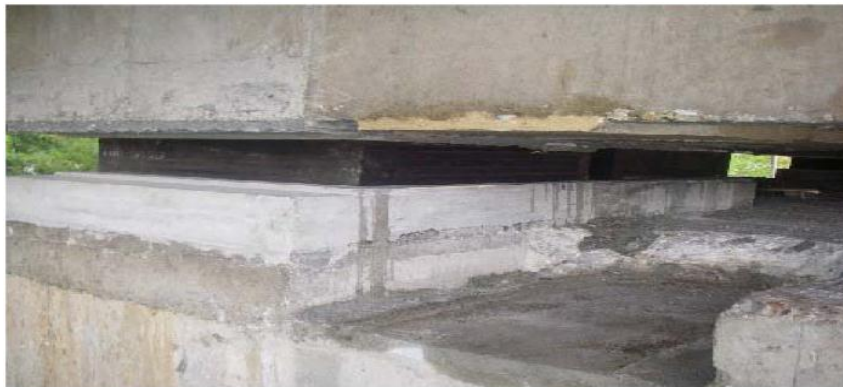
Figure IX.5 : Appareil d'appui en élastomère fretté.
