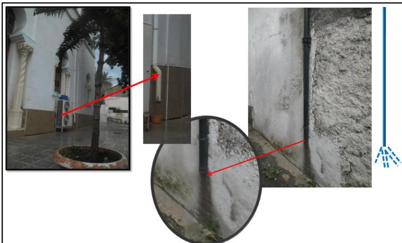
Fig 52 : Photos illustratives des descentes des eaux pluviales
