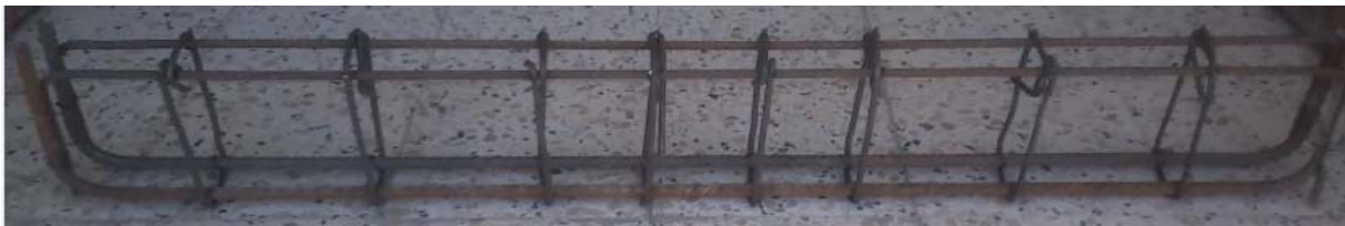
Figure II.48 : Photo du ferrailage
