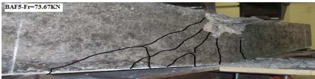
Photo 6 : rupture de la poutre BAF5 : présence des fissures en zone d'effort tranchant, mais la rupture s'est produite par éclatement du béton en zone de flexion - fendage du béton (zone centrale de la poutre).
