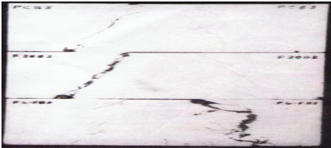
Figure I.57 : Mode de fissurations des poutres testées pour a/d=8 [ROB. 82]
