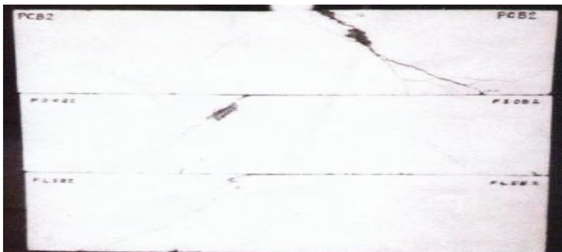
Figure I.56 : Mode de fissuration des poutres testées pour a/d= 16 [ROB. 82]
