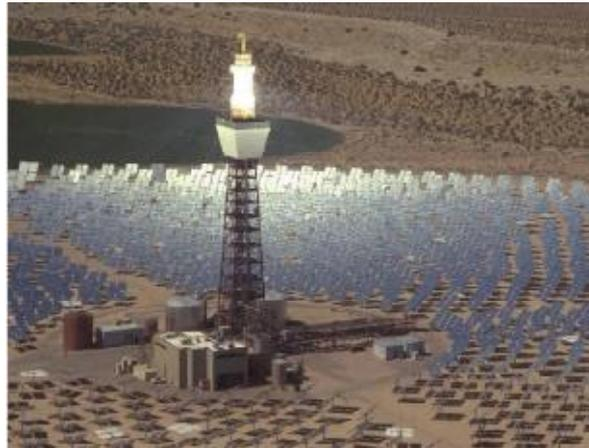
(Figure I-4) : Panneau solaire thermodynamique [10].
