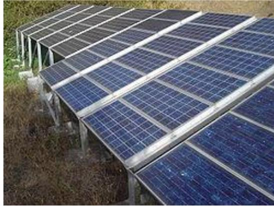
**Figure (I-2) :** Panneau solaire photovoltaïque [8].
