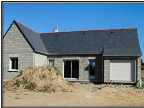
**Figure 141 :** Toiture en tuile en ardoise naturelle.
