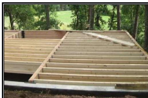
**Figure 160:** Réalisations d'un plancher en bois.
