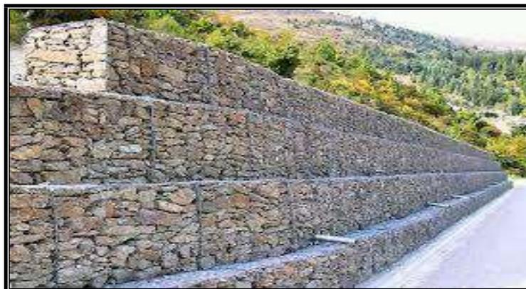
**Figure 145** : Mur de soutènement en gabionnage de pierre.
