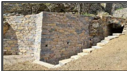
**Figure 164:** Mur de pierre en maçonnerie de moellons.
