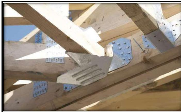
**Figure 157:** Connecteurs métalliques pour travée en bois.
