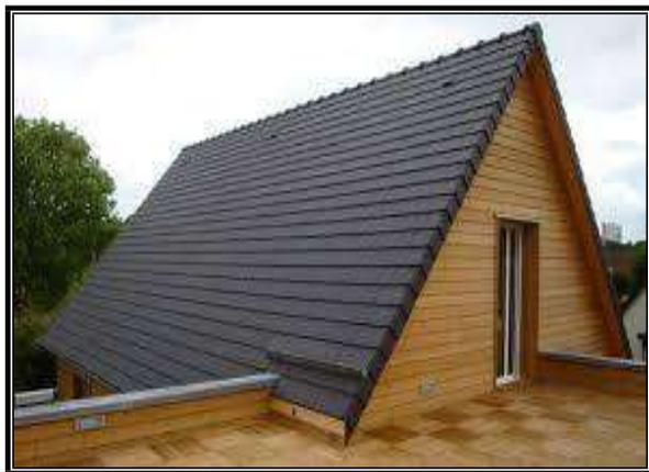
**Figure 140 :** Toiture en tuile en ardoise artificielle.
