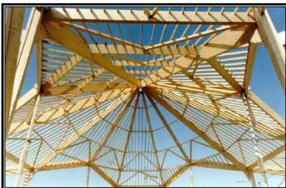
**Figure 135 :** Charpente complexe en lamellé collé.
