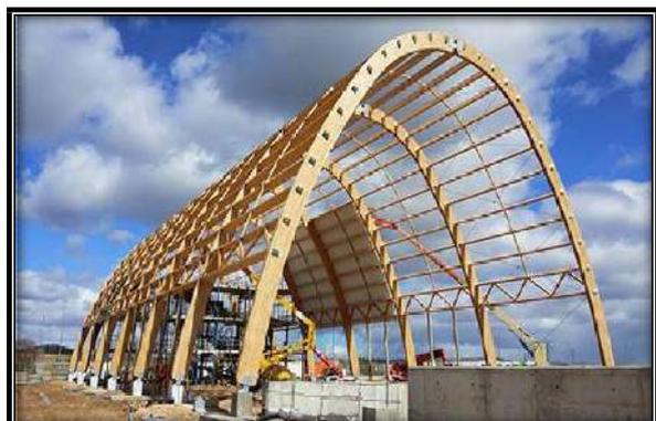
**Figure 136 :** Couverture complexe en lamellé collé.
