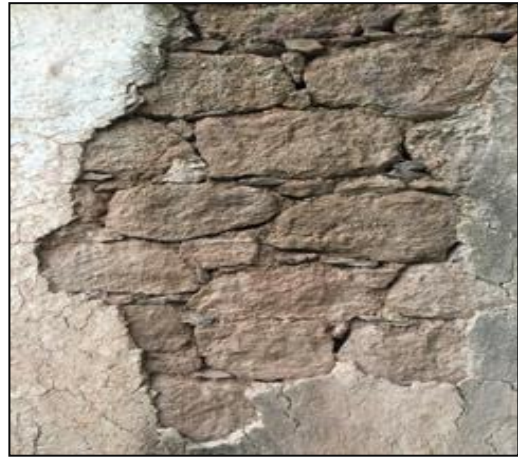
Figure 4: Revêtement de mur extérieur au sein du village Iguersafene.
