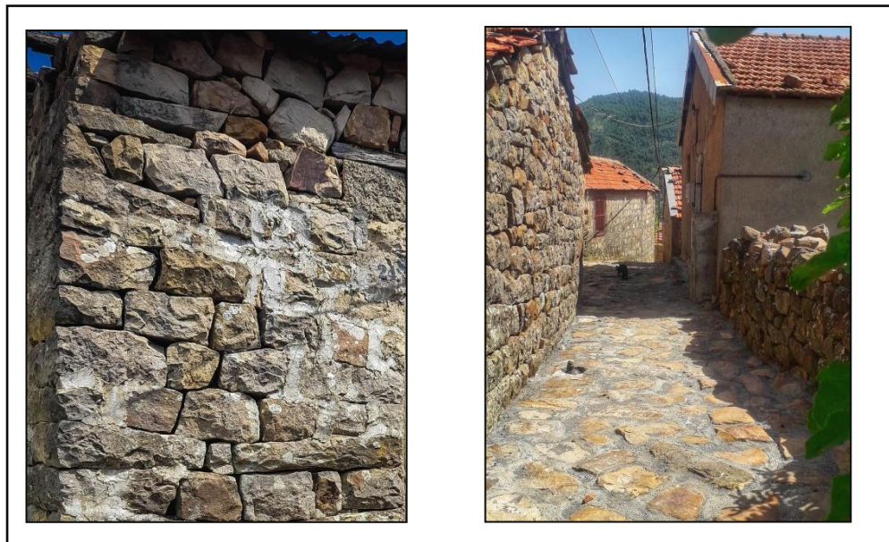
Figure 59: renforcement d'un mur et d'un pavé en pierre sèche et avec du béton au sein du village Iguersafene.
