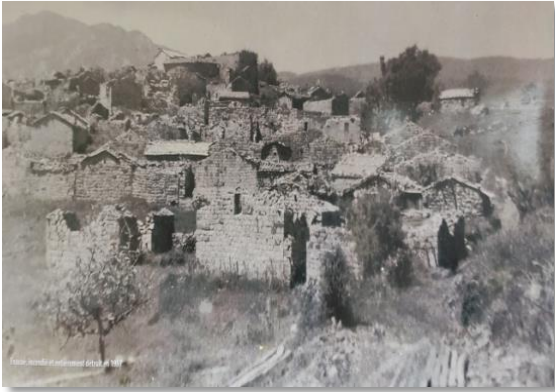
Figure 40: : Village Iguersafene rasé en 1957 .Source : Auteur.
