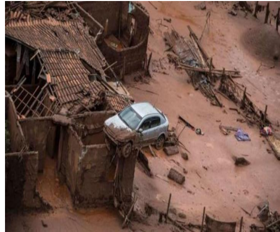
Figure 9 : Coulée de boue meurtrière au Brésil Source : https://www.leparisien.fr/environnement/coulee-de-boue-meurtriere-au-bresil-la-justice-reclame-un-dedommagement-colossal-04-05-2016-5766701.php
