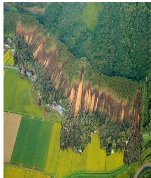
Figure 3 : Japon, glissements de terrain et disparus après un fort séisme à Hokkaido Source : https://actu.fr/monde/japon-glissements-terrain-disparus-apres-fort-seisme-hokkaido_18465917.html
