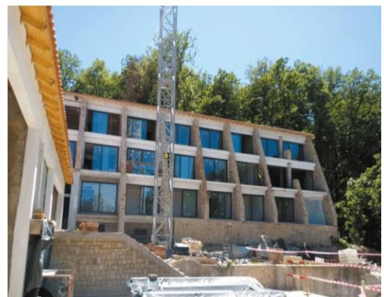
Figure 51: Hôtel Tamgout en travaux de réhabilitation. Source : https://elwatan-dz.com/renovation-de-lhotel-tamgout-yakouren-taux-davancement-de-65
