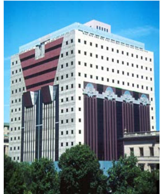
Le Portland Building, à Portland, dans l'Oregon.
