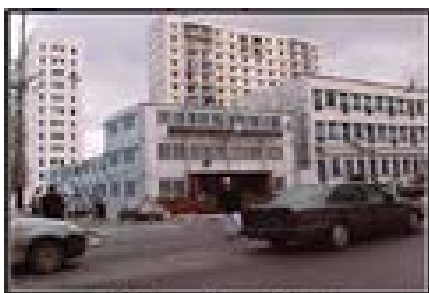
3/ Bâti en bon état (Administration, résidence).
