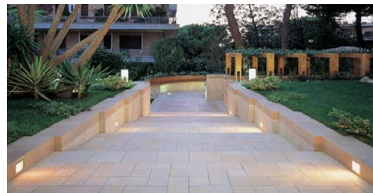
Revêtement en carreaux de pierres
