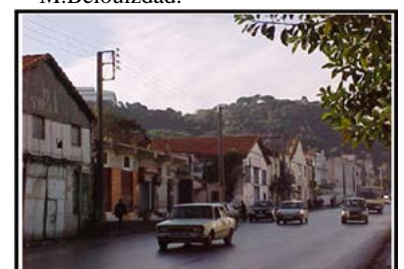
5/Gabarit faible (zone des abattoirs).
