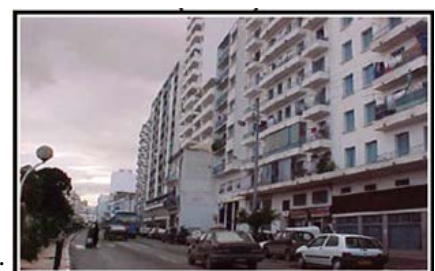
2/Gabarit important sur la rue M.Belouizdad.
