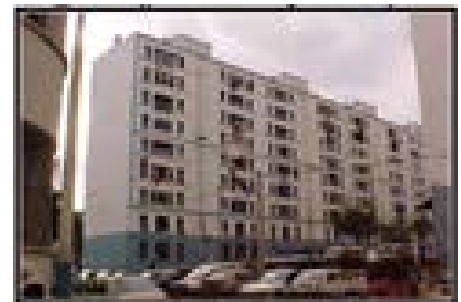
2/ Bâti en bon état (HLM).
