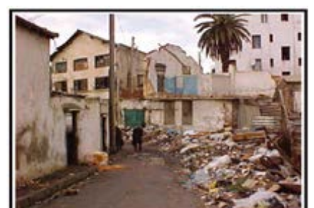
5/ Bâti en état vétuste Zone des abattoirs).
