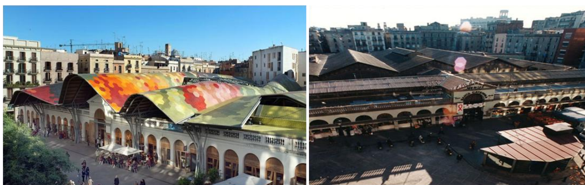
Figure 33 : Réhabilitation du Santa Caterina Market à Barcelone
