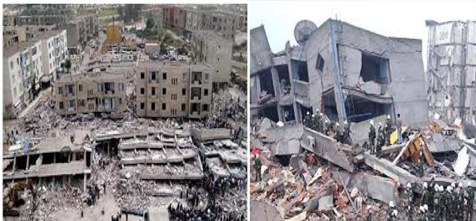
Figure II.5 : Effet du séisme de Boumerdès (Algérie, 2003) [2].
