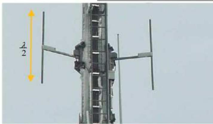
Figure I-19 : Dipôles verticaux d'un émetteur FM
