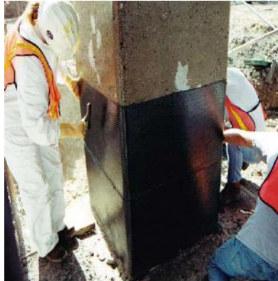
Figure I.19: Confinement des colonnes par stratification directe
