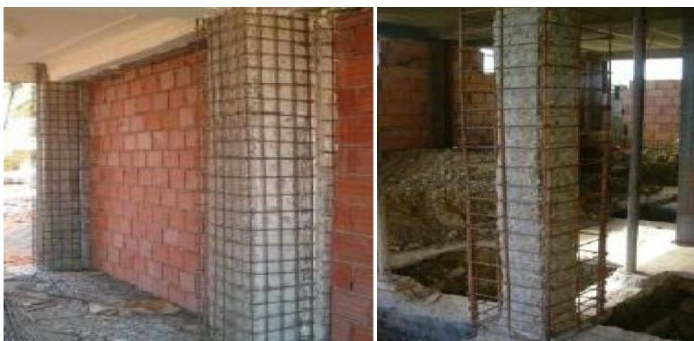
Figure I.11 : Préparation des poteaux pour le chemisage en béton armé
