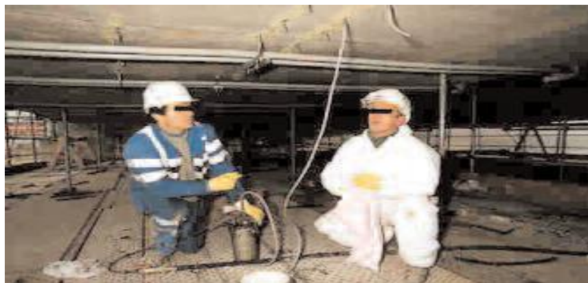
Figure I.4: injection de fissures au pont de Châlons-en-Champagne [7]
