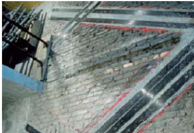
Figure I.16: Réhabilitation d'un mur en maçonnerie (Suisse) [41] [14] [35]
