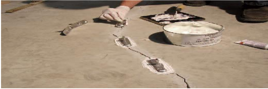
Figure I.5 : fissure en cours de cachetage
