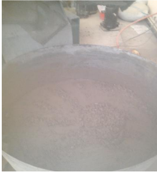
Figure. III.3. Malaxage du béton.
