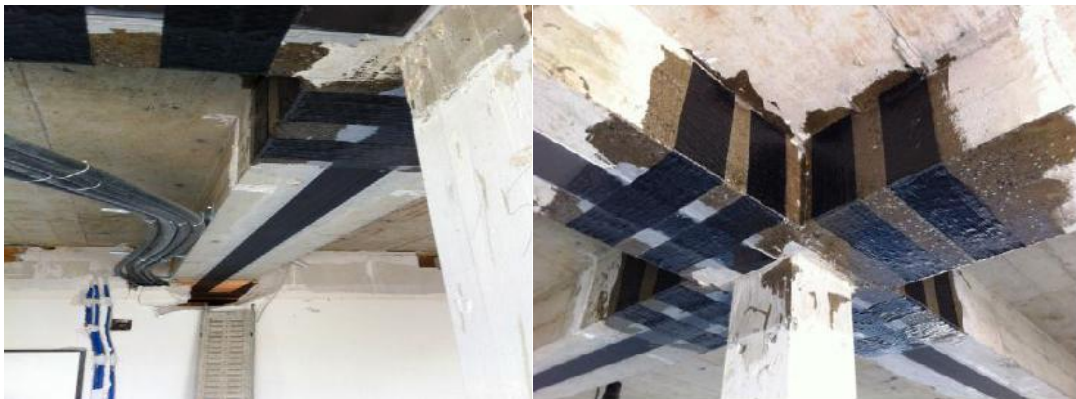
Figure I.14: poutres en BA renforcées par matériaux composites.
