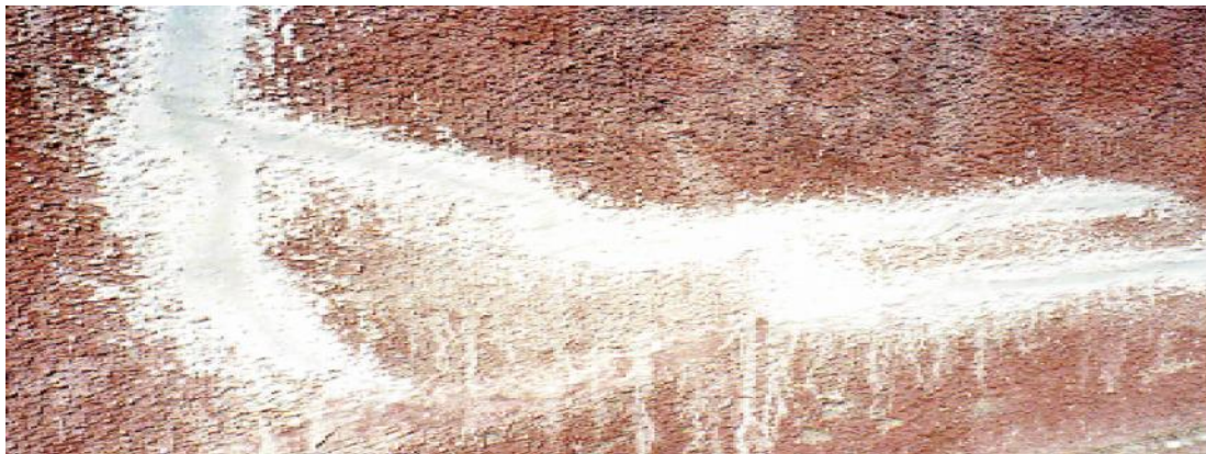
Figure I.6 : calfeutrement de fissures à l'aide d'un mortier à base de liants hydrauliques
