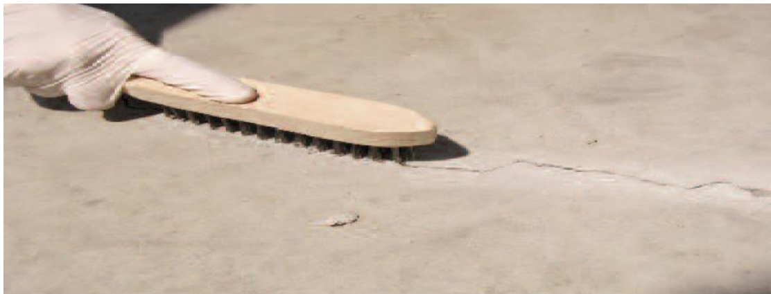
Figure I.2 : nettoyage d'une fissure avec une brosse métallique
