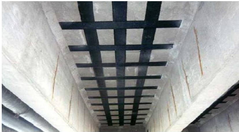
Figure I.18 : Renforcement d'une dalle de pont
