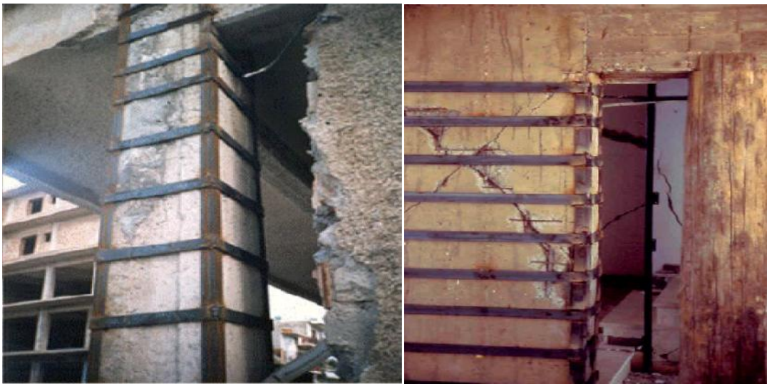
Figure I.12 : Chemisage en acier
