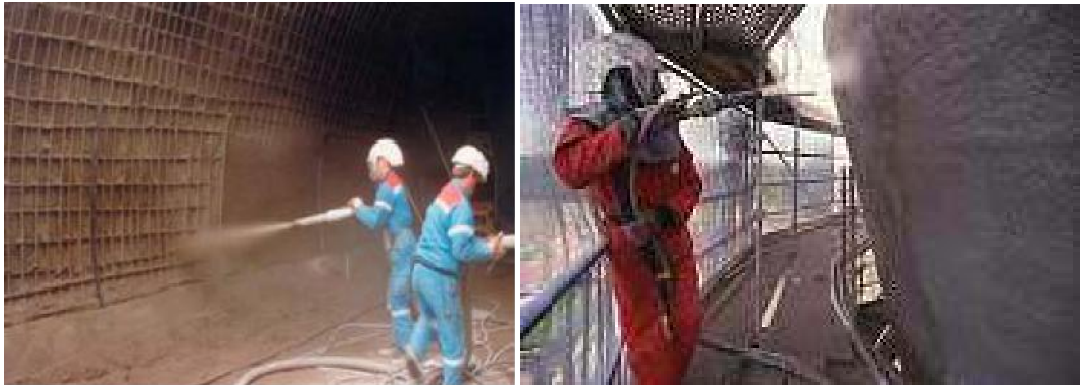
Figure I.10: Renforcement au moyen d'un béton projeté
