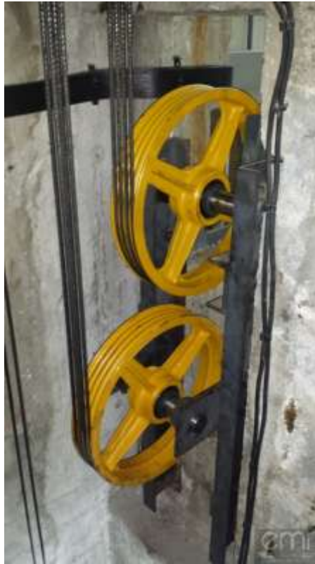
Figure 25: Système de traction
