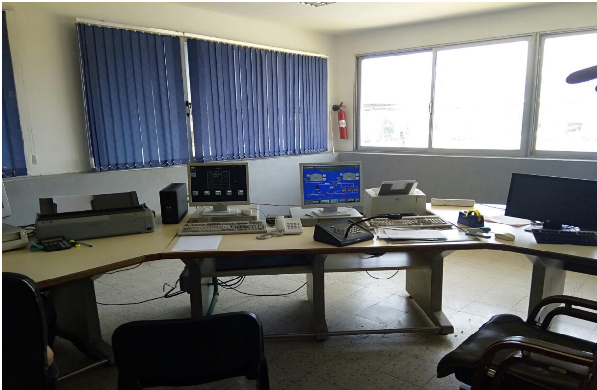
Figure I.7: poste de contrôle et de supervision.
