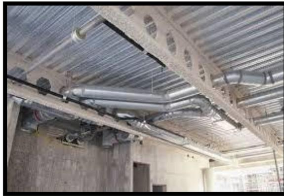
**Figure 102:** Poutre alvéolaire.
