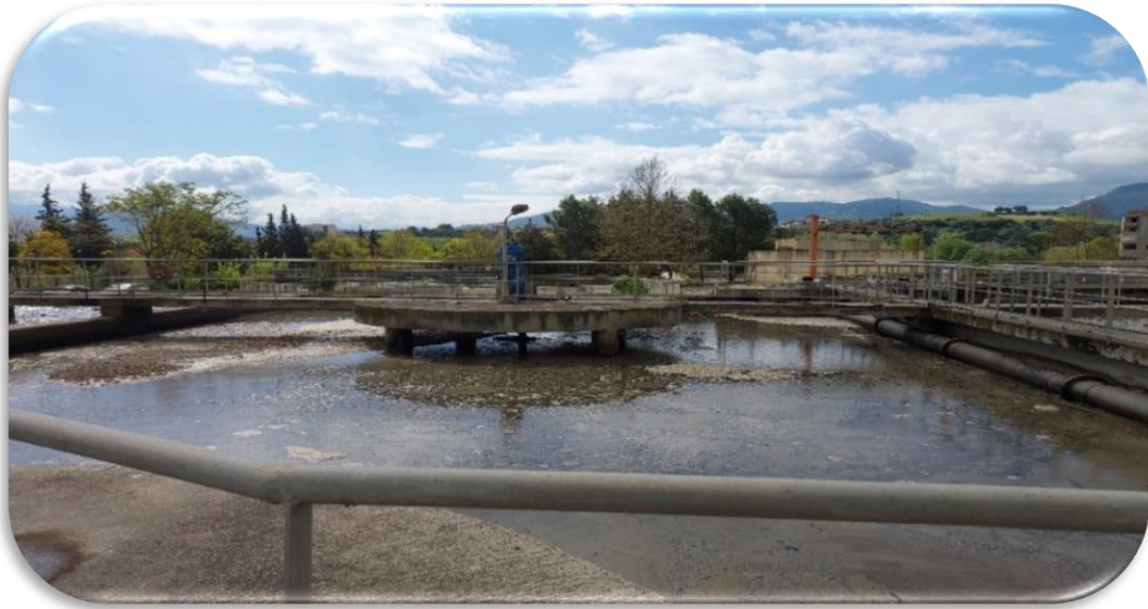
Figure 14. Bassin de stabilisation.
