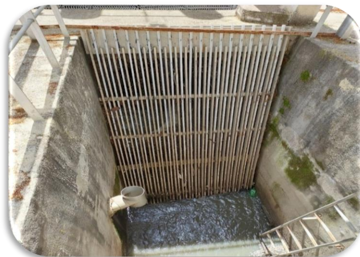
Figure 7. Dégrillage grossier.
