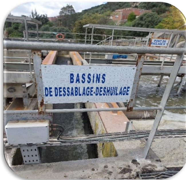
Figure 10. Dessablage et déshuilage.
