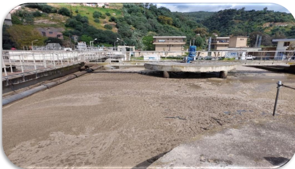
Figure 12. Réacteur biologique (bassin d'aération).
