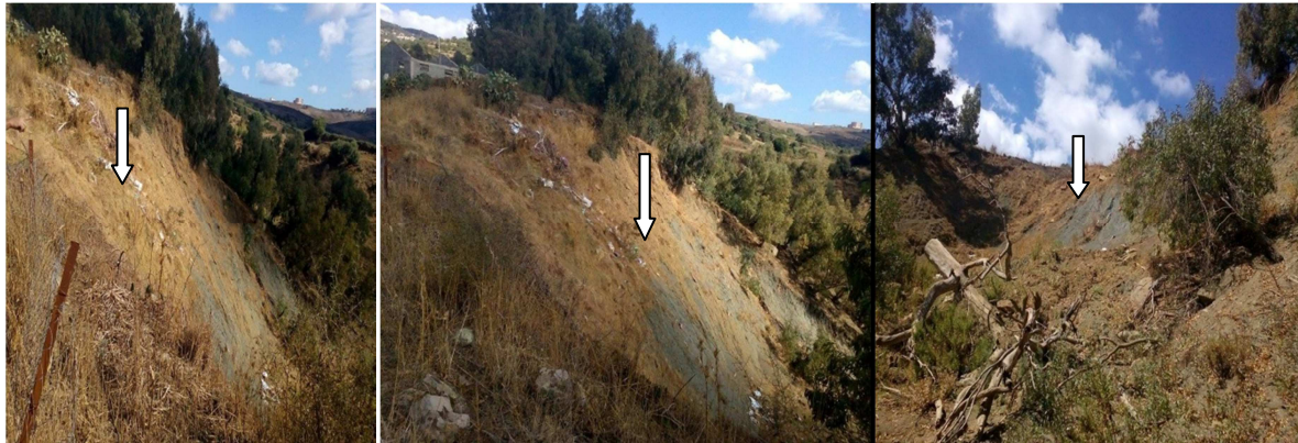
Fig. II.6 : Glissement de terrain à Tala N'Tgana (2016)
