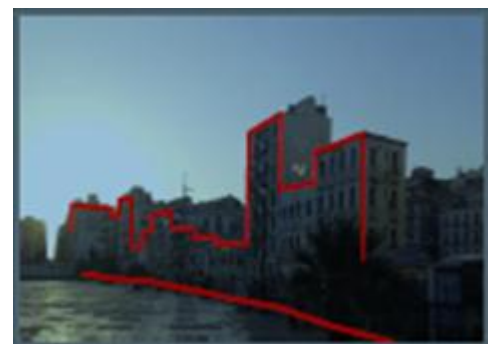
Figure48 :photo sur la voie commandant mira
