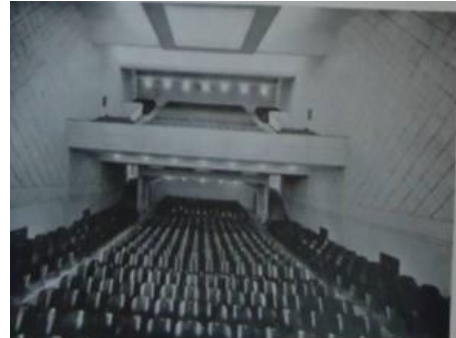
Le cinéma Le Piazza. Intérieur Revue chantier. Janvier 1939
