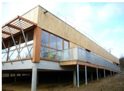
Figure 136 : Façade latérale droite Source : www.belliardconstruction.com
