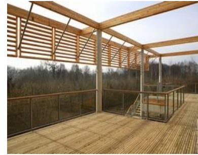
Figure133 : Terrasse Source :www.darchitectures.com
