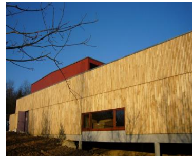
Figure 138 : Façade latérale gauche Source : www.belliardconstruction.com
