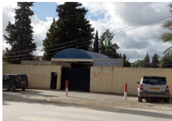
Figure 14 : Lycée Stambouli. Source : Auteurs.
