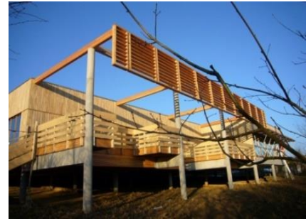
Figure131 : Terrasse Source :www.belliardconstruction.com
