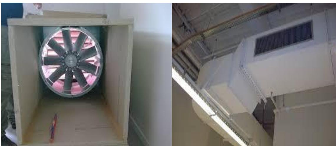
**Figure 4.5 :** Représentation d'un ventilateur de désenfumage d'extraction
